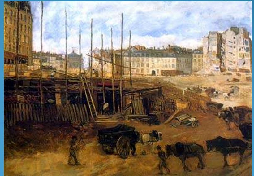
Percement avenue de l'Opéra
